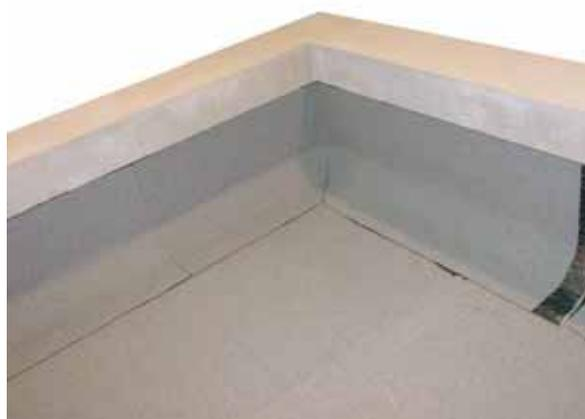
5.20. После завершения наклейки материала на примыкания и формирования всех внутренних и внешних углов, приступают к завершающей стадии выполнения кровли. Верхний край материала закрепляют с помощью металлической рейки. Рейку крепят саморезами с помощью электрошуруповёрта. Расстояние между рейками по плоскости и в углах должно быть 5-10мм.
