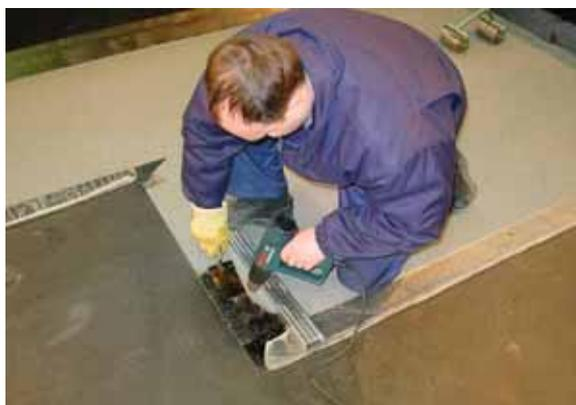
Для формирования качественного торцевого нахлеста, в конце рулона отрезают уголок материала. Размер уголка 150 мм в длину и 80-100 мм по ширине.
