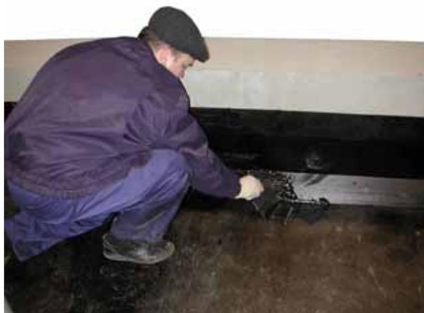
5.11.2. После укладки материала «Техноэласт-Прайм ЭММ», его поверхность прокатывают силиконовым роликом. Это позволяет увеличить сцепление материала с основанием и выдавить излишки мастики.
