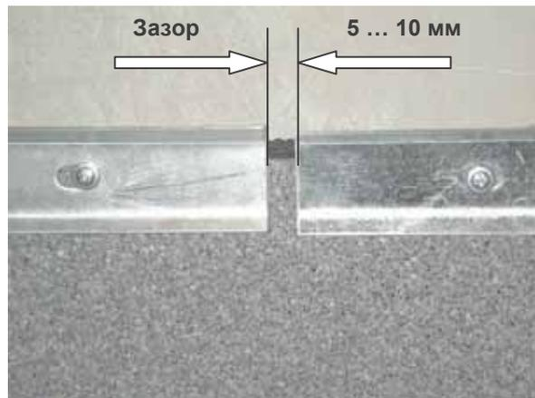
Верхний отгиб краевой рейки заполняют битумным герметиком или битумно-полимерными мастиками "Вишера" или "Фиксер". Мастики наносят с помощью шпателя.
