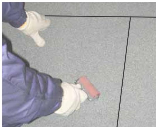
Прикатать место склейки материала силиконовым роликом. Выдавившуюся мастику из-под бокового и торцевого шва присыпают сверху посыпкой. Нанесенную посыпку необходимо вдавить в битумно-полимерную мастику.
