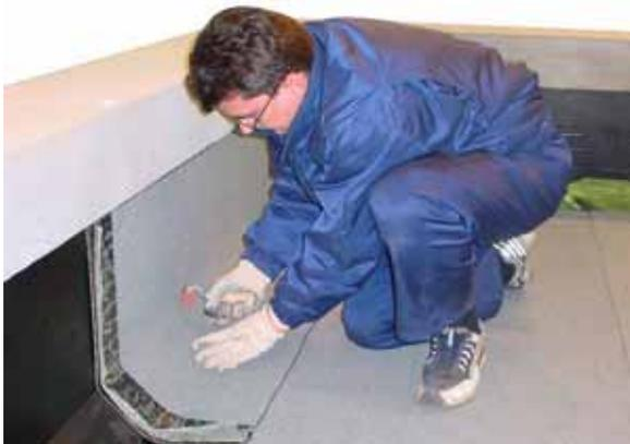
При формировании внутреннего угла кровли, куски материала на примыканиях подрезают по месту. В углах кровли материал может отойти от поверхности, после высыхания мастики. Такие места прогревают феном горячего воздуха и прижимают к основанию.
