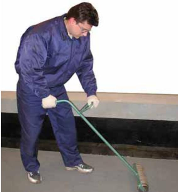
Приглаживание материала широкой щеткой необходимо для того, чтобы убрать пустоты и выгнать пузыри воздуха из под материала. Приглаживание производят от центра рулона к краям, выгоняя воздух через края полотнища.
